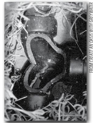
Vista de un corte de un separador de flujo, un adaptador que se limpia por sí solo en la mayor parte, sin filtración.
