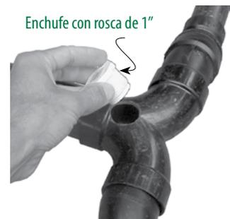
Un separador de flujo retro-adaptado con acceso para inspección. El acceso está sellado con un enchufe con rosca.
